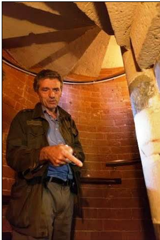
Nella foto Dario Gaviglio del Centro Studi Vercellae che, durante il sopralluogo presso il Sant'Andrea, evidenzia alcune fenditure di recente formazione nelle colonnette che compongono il pilastro centrale della scala interna, conducente al sottotetto (foto di Simone Saviolo)
